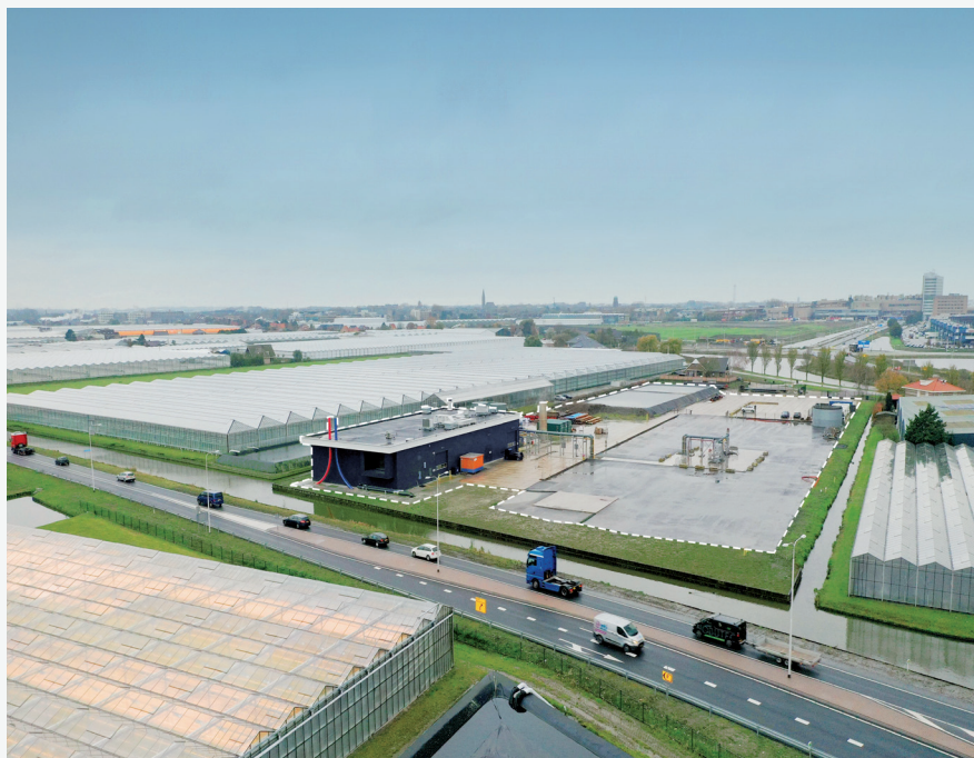
Ruimtebeslag van een aardwarmtelocatie in een tuindersgebied.
